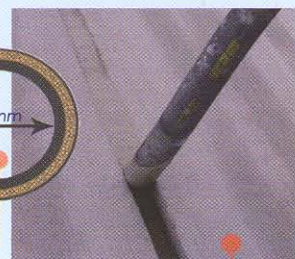
Voegen vullen met betonpompslang
