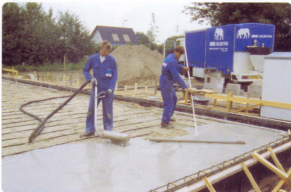
Schuimbeton. Voor de snel beloopbare en sterke werkvloer. Homogeen van samenstelling. Elke vierkante meter!
