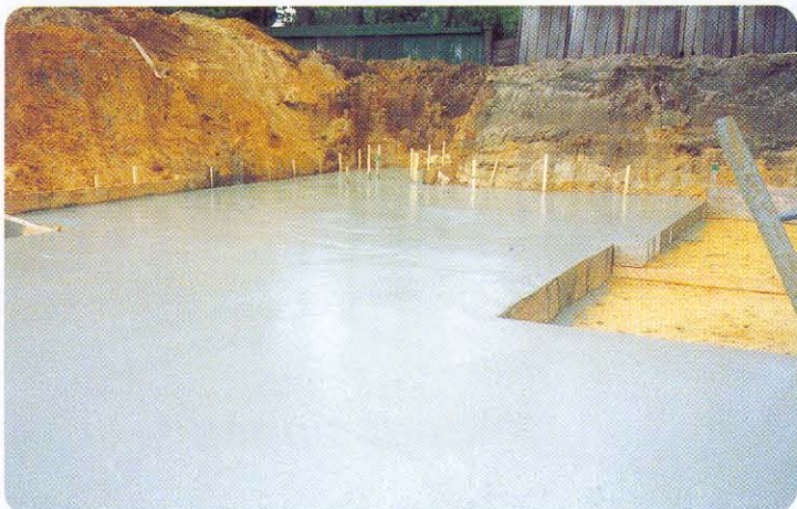
Werkisolatievloer 25 cm dik van 500 kg/m 3 en een R-waarde van 2.5
