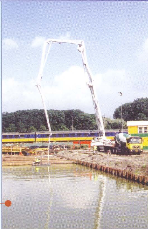
Spooronderdoorgang gestort onder 5% afschot
