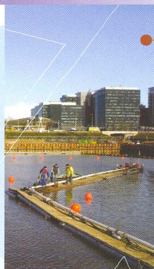
Onderwater betonstort van 7100 m 3 met 80 meter drijvende leiding
