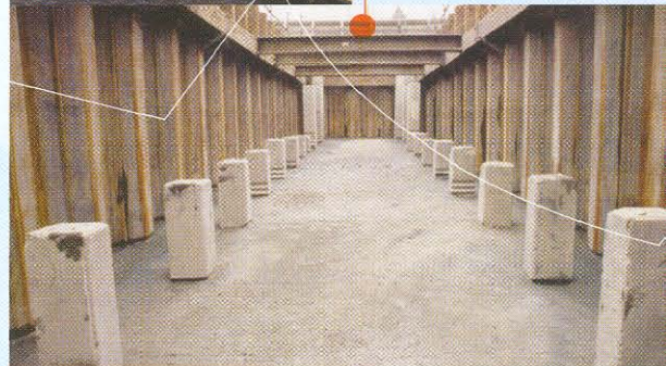
Onderwaterbeton gestort onder 5% afschot
