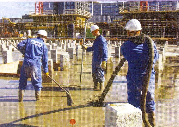
Het aanbrengen van een 7,5 cm dikke uitvulling van celbeton
